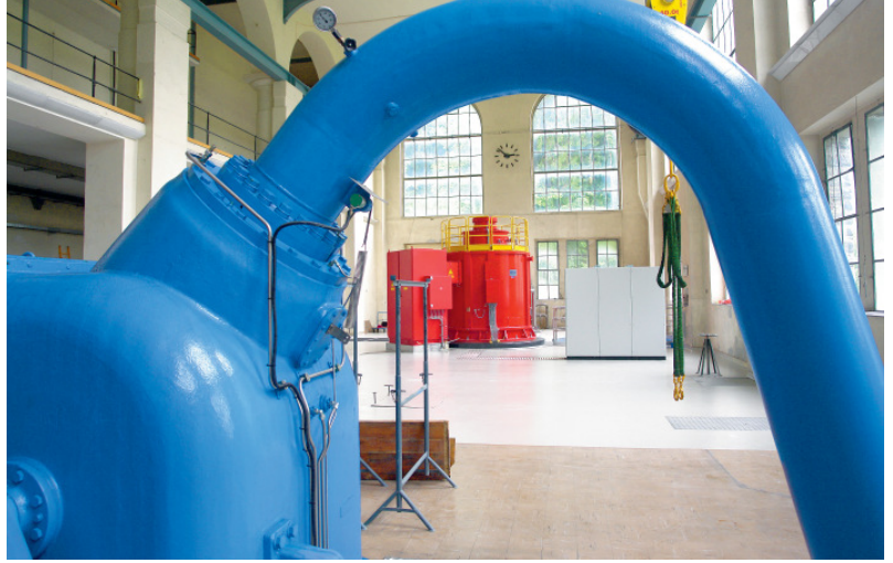
Ersatz von zwei alten Generatoren durch eine neue Turbine (rot) im Kraftwerk Obermatt.
